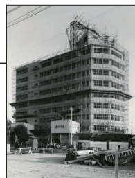
③建設中の 生産性本部ビル
